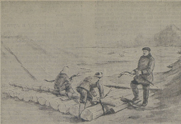
Когда заканчивали последние работы, бухту начала заливать всё прибывающая вода.
